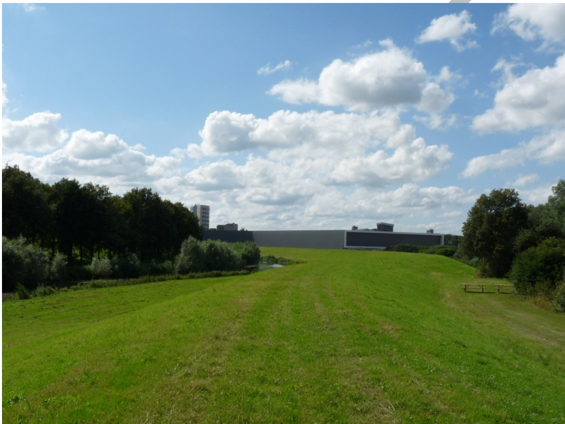
Foto 3: Bestaand dijklichaam Schipbeek tussen Hanzepark en aansluiting op oostzijde Zutphenseweg (deelproject 2b; Schipbeekpad)
