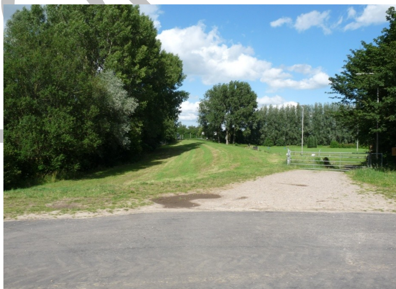
Foto 2: Dijklichaam bij Molbergsweg als begin van de Fietsbrug Zuid. In verre achtergrond het spoor Deventer-Zutphen en Siemelinksweg (deelproject 2c; Fietsbrug Zuid)
